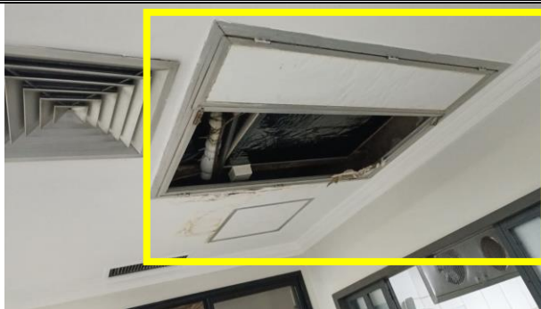
Alçapão no forro de acesso a máquina existente.
