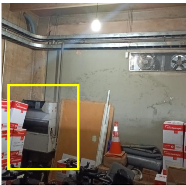
Local da condensadora existente, no estacionamento.
